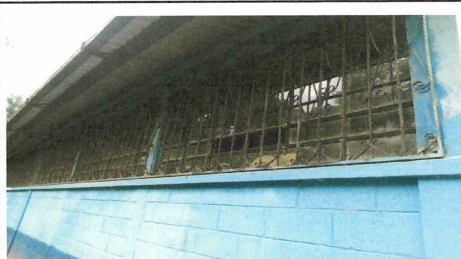
Foto 2: SUSTITUCIONDE BALCONES, EN LA PARTE NORTE, LADO DE ATRÁS
