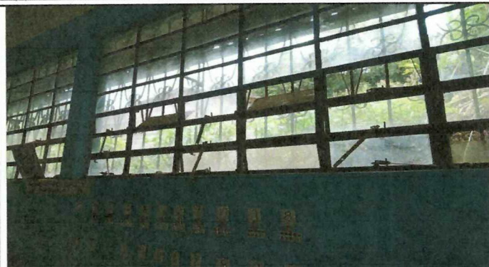
Foto1: SUSTITUCIONDE VENTANAS A PVC, EN LA PARTE NORTE, LADO DE ATRÁS
